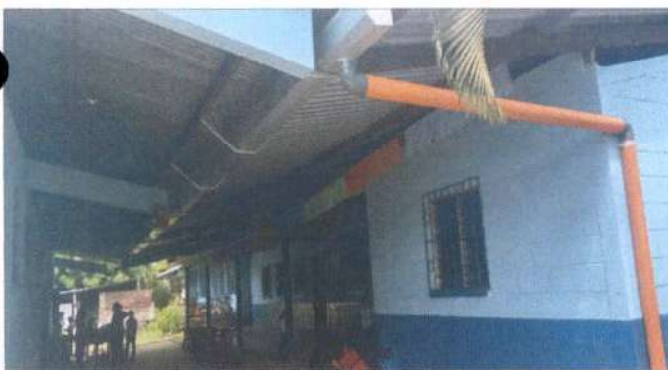
Foto 5: MÓDULO 3 CANALES SUSTITUCIÓN DE CANAL DE METAL Y SOPORTES DE METAL
